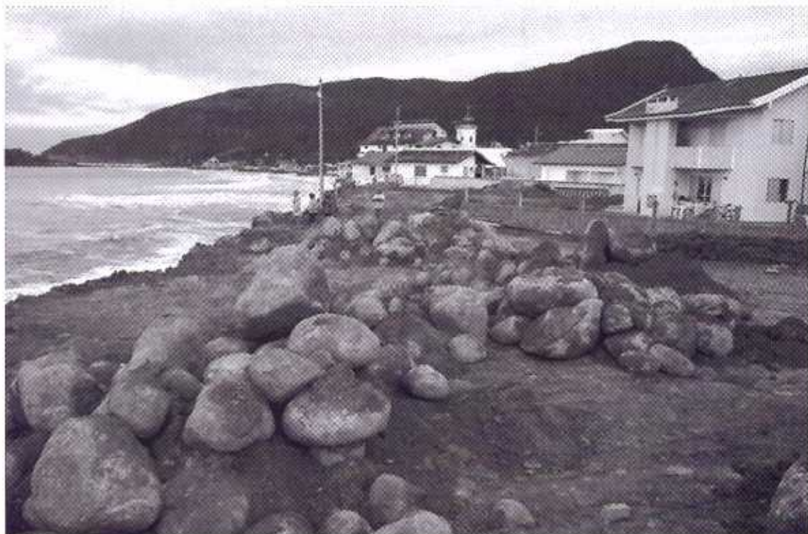
As toneladas de pedras não foram suficientes para conter a destruição causada pelas ressacas (Lucas Sampaio)
