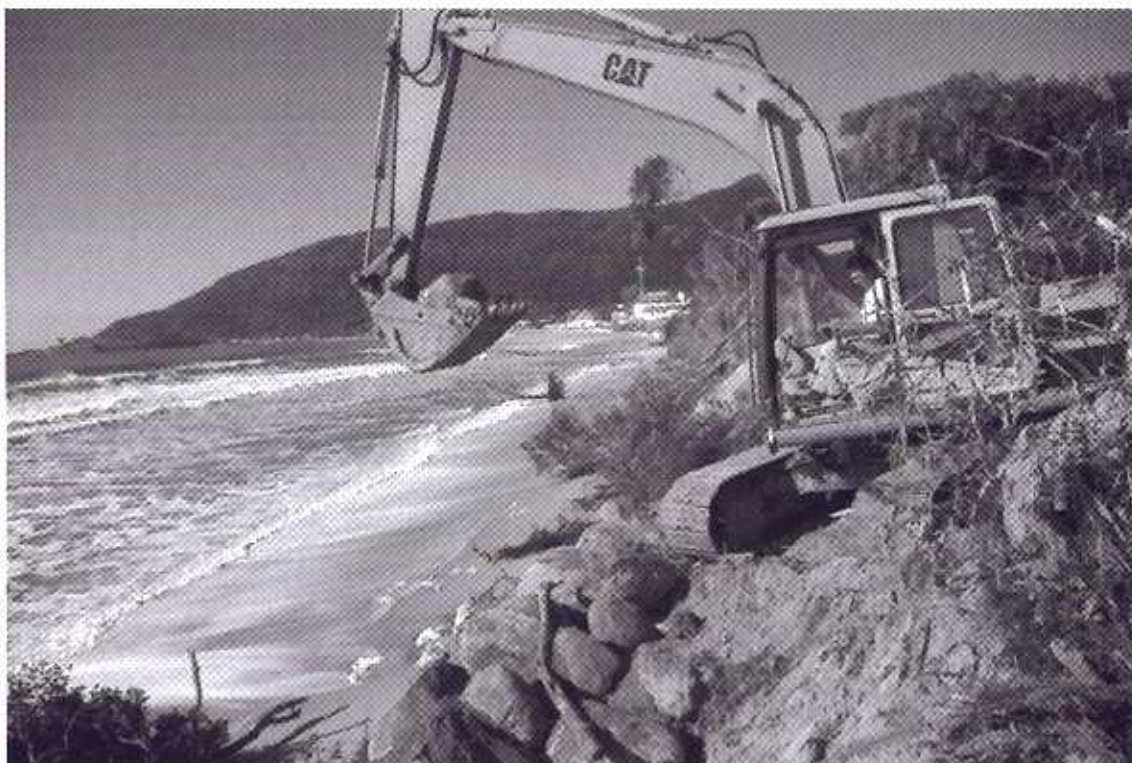
Tratores e caminhões contratados pela prefeitura pela primeira vez trabalham no local (Edu Cavalcanti)
